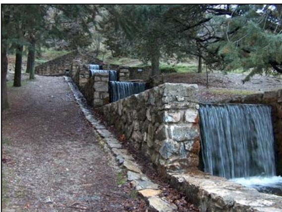
La captación consiste en un gran pilar techado que desagua por un canal escalonado hacia un estanque y éste a su vez hacia un arroyo. Desde el pilar parte la captación de abastecimiento a Torres que pasa por una caseta en la que existe una válvula de compuerta y un contador. En los extremos laterales del
